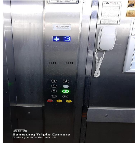
Şekil TS.7.1.7/6 Asansör İçi – Telefon ve görme engelliler için tuşlar
